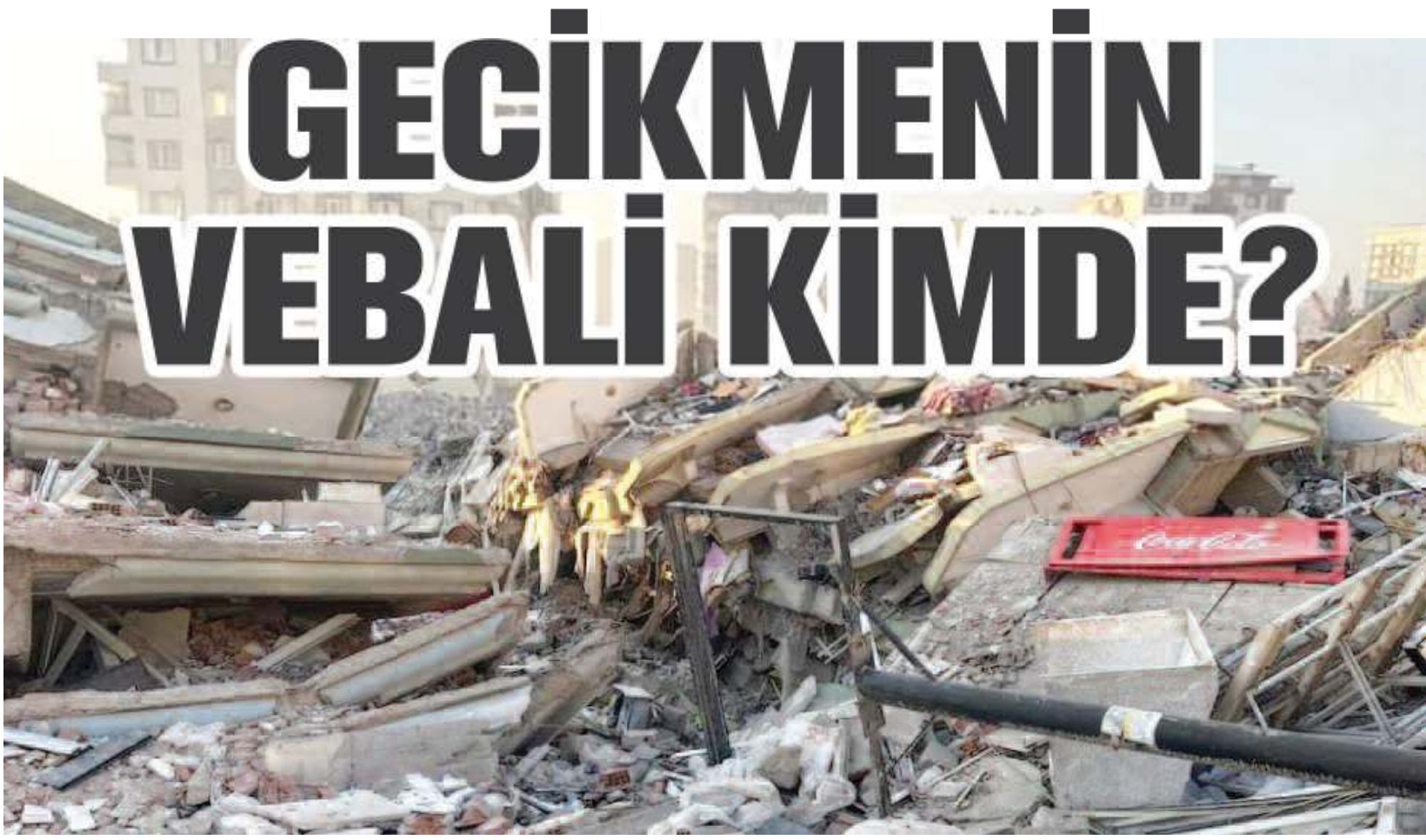
Maraş'ta 6 Şubat'ta meydana gelen depremlerin büyük yıkıma neden olduğu şehirlerden Adıyaman da kurtarma ve yardımın çok geç geldiği yerlerden.
